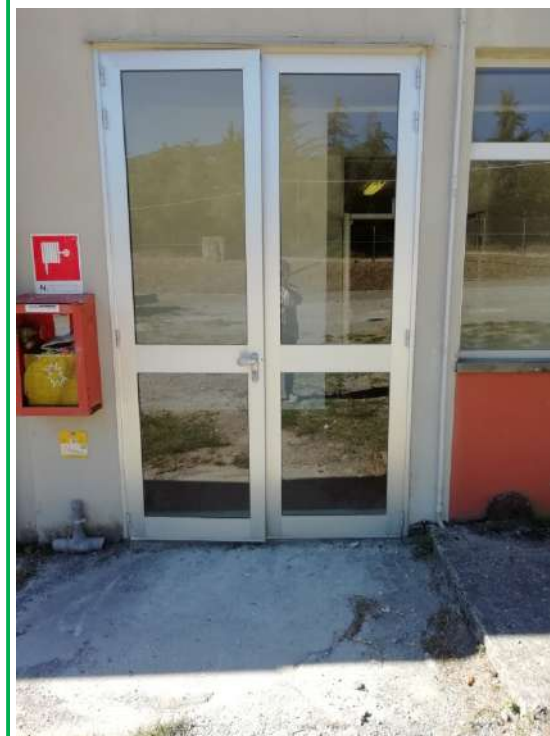
PORTA DI EMERGENZA (piazzale parcheggio palestra)
